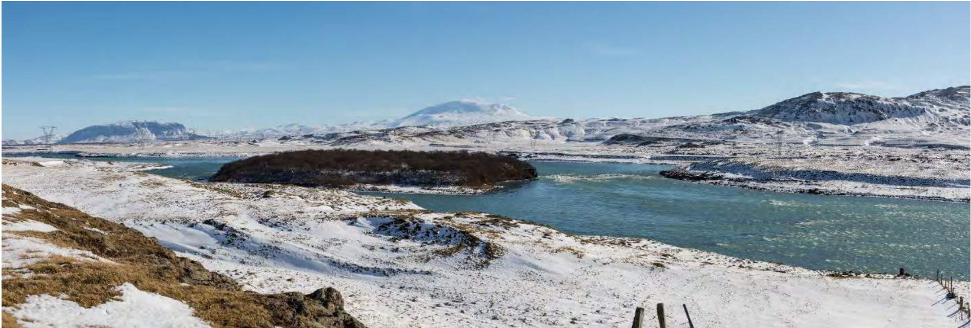
Mynd 35 Sjónarhorn 25. Mynd tekin neðan við fyrirhugaða stíflu, horft er í norðaustur upp með ánni, í átt að Viðey og fyrirhugaðri stíflu - fyrir framkvæmd.
