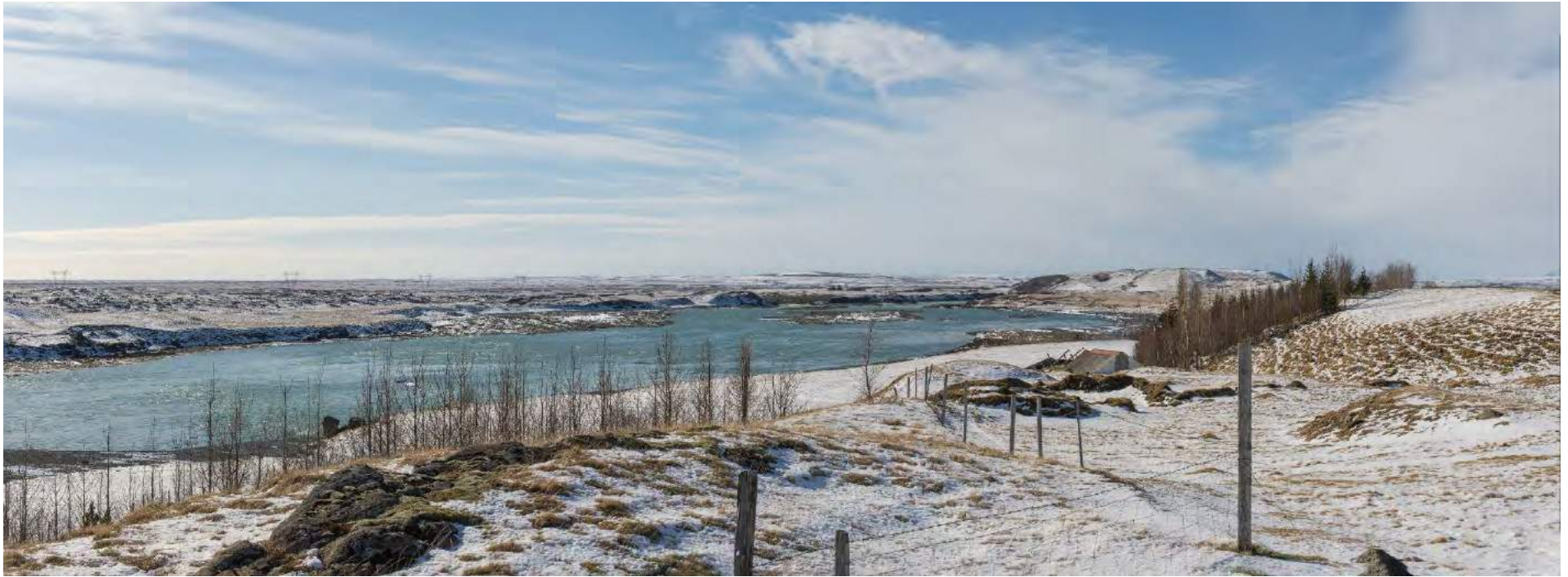
Mynd 38 Sjónarhorn 25. Mynd tekin neðan við fyrirhugaða stíflu, horft er í suðsuðvestur niður með Þjórsá og sýnir breytt rennsli - eftir framkvæmd.
